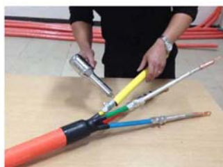
33、用铜铝过渡端子将连接器和地线相连接，并拧紧螺母
