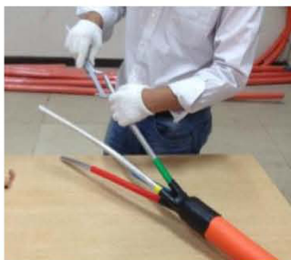
12、端头铝管剥除长度约 70-80mm 左右
