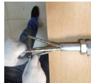
23、根据端子的插入深度，确定云母绝缘剥去长度
