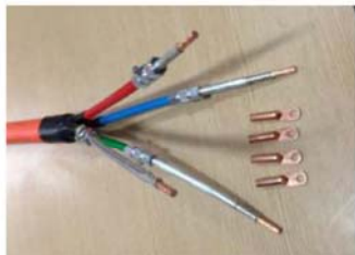
27、使用对应的铜鼻子，将其套入剥好的线芯
