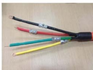
34、终端接头安装后的电缆
