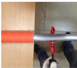
13、可安装需要适量剥除铝管长度
