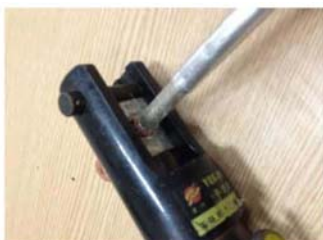
28、用压线钳将接头压紧，压接顺序是从端子头部向导体连接端顺序压接
