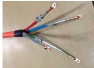
29、用压线钳将接头压紧，压接顺序是从端子头部向导体连接端顺序压接
