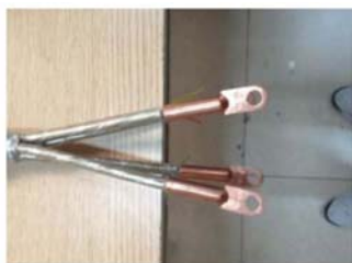
27、使用对应的铜鼻子，将其套入剥好的线芯
